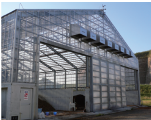
食品残渣堆肥化ハウス
