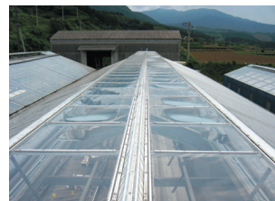
天窓に溜まった水
