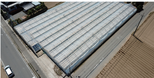
1988년 설치/사이타마 현/토마토(두께 60µm/2020년 촬영)
